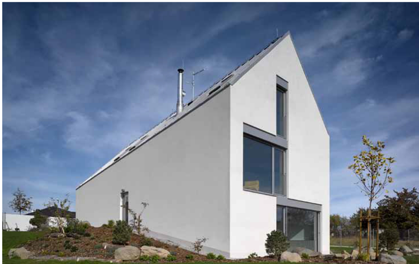
Autoři návrhu se nebránili regulativu na šikmou střechu, protože místo je pověstné sněhovými nádlkami. Projekt ovlivnil i další regulativ územního plánu, a to, že dům musí mít jedno nadzemní podlaží a podkroví.
