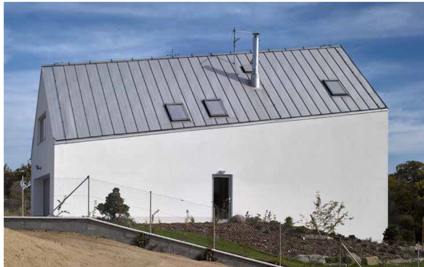
Sklon hřebene proti svahu kopíruje vnitřní prostorové uspořádání, nezvyklá forma domu tak odpovídá příčnému rozdělení půdorysu a posunu úrovní o poloviční výšku patra
