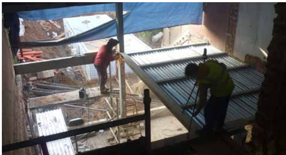
Ocelové nosníky a sloupy se usazovaly ručně za pomoci kladek a lan, popřípadě lešení
