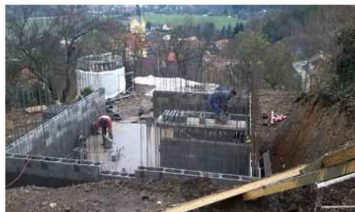
Na betonových pasech je železobetonová deska, pod kterou je podkladní vrstva betonu a 20 cm pěnoskla. Betonové stěny po obvodu doplňují dvě nosné stěny schodiště, které fungují jako výstužná žebra směrem do svahu zajišťující tuhost stavby.
