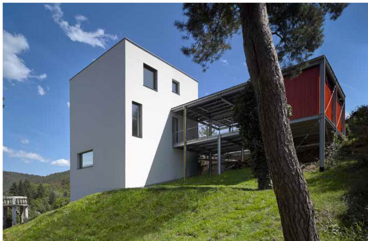
Z ulice se do domu vchází přes ocelovou konstrukci krytého stání pro auta
