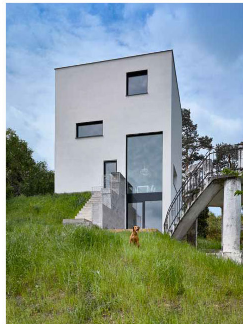
Na zahradě s pozůstatky romantického altánu vznikla stavba s přísnou pravoúhlou geometrií, kterou autoři návrhu podpořili bílým provedením v interiéru
