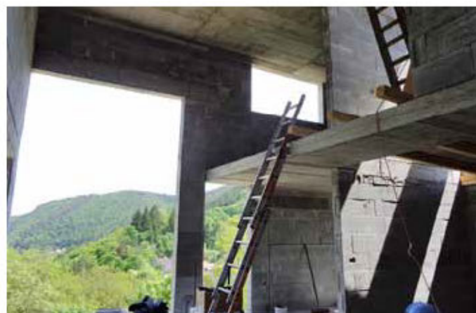
Čtyřpatrový dům neměl ve fázi hrubé stavby schodiště – v jednom patře tedy byla provizorní podesta, aby bylo o co opřít žebřík
