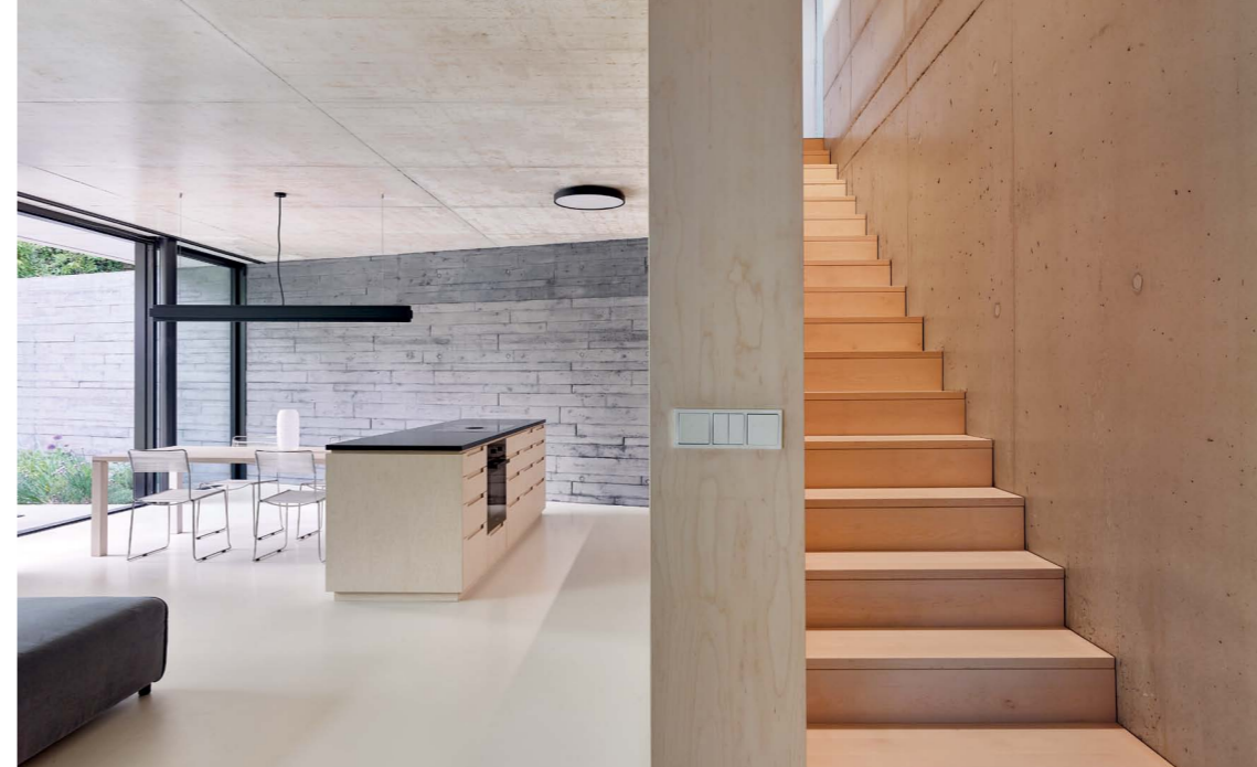
Strop z bílého betonu měl jiný typ bednění, takže působí, jako by byl proveden v jiném odstínu. Velký vliv má na vnímání barvy také jiné osvětlení
