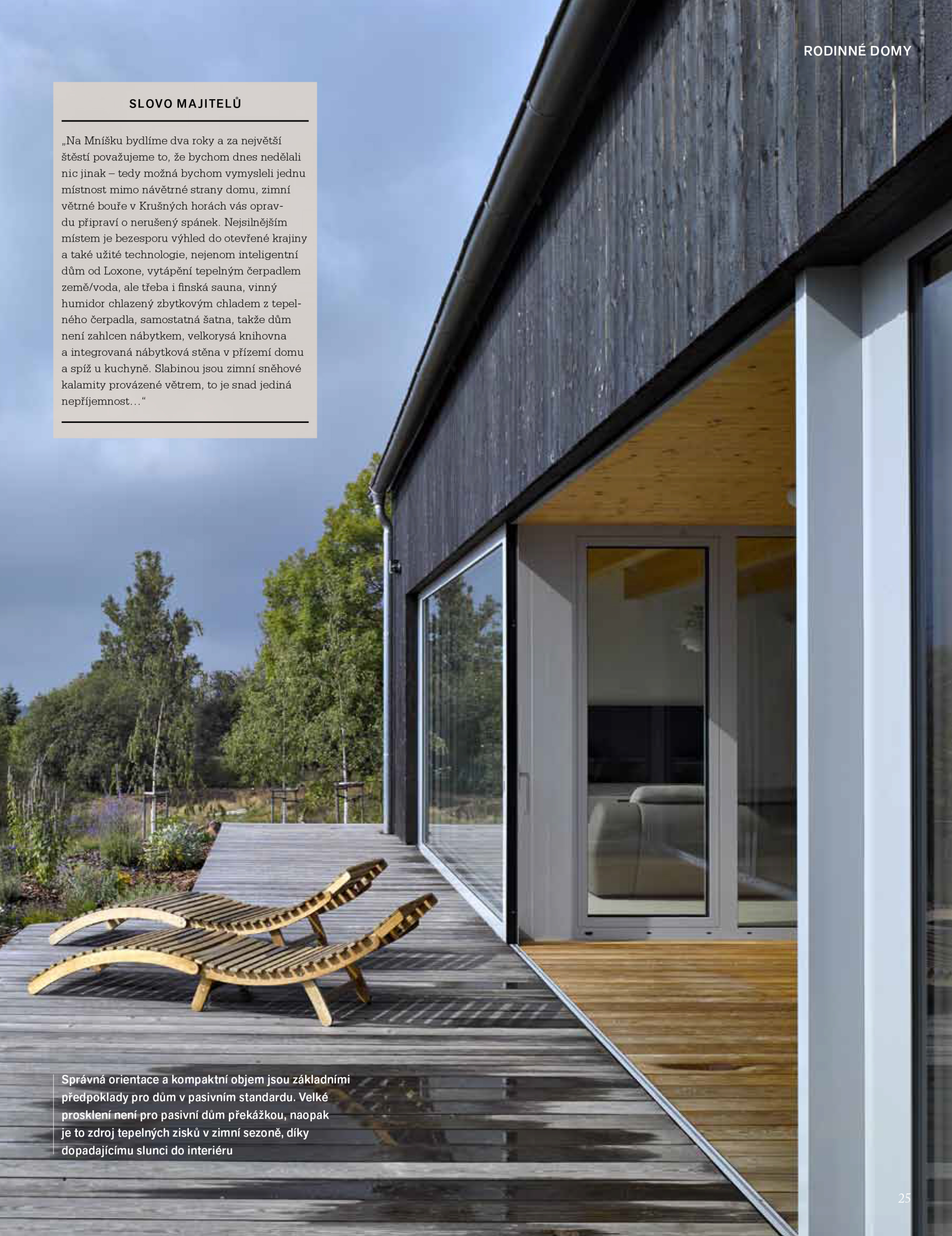
Fasáda domu i garáže je z opalovaného severského modřínu s vertikálním vedením prken, navržena převážně jako provětrávaný fasádní systém. Malá část do technické místnosti je navržena jako kontaktní fasáda
