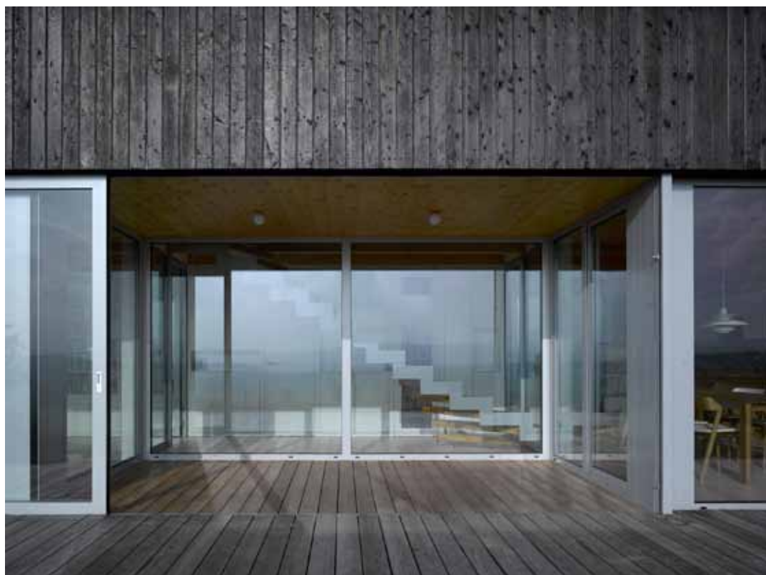
Fasáda domu je z mořeného severského modřínu, okna mají hliníkové rámy. Nosnou konstrukci tvoří zdivo z keramických tvarovek HELUZ Family 25 a doplňujících tvarovek.
