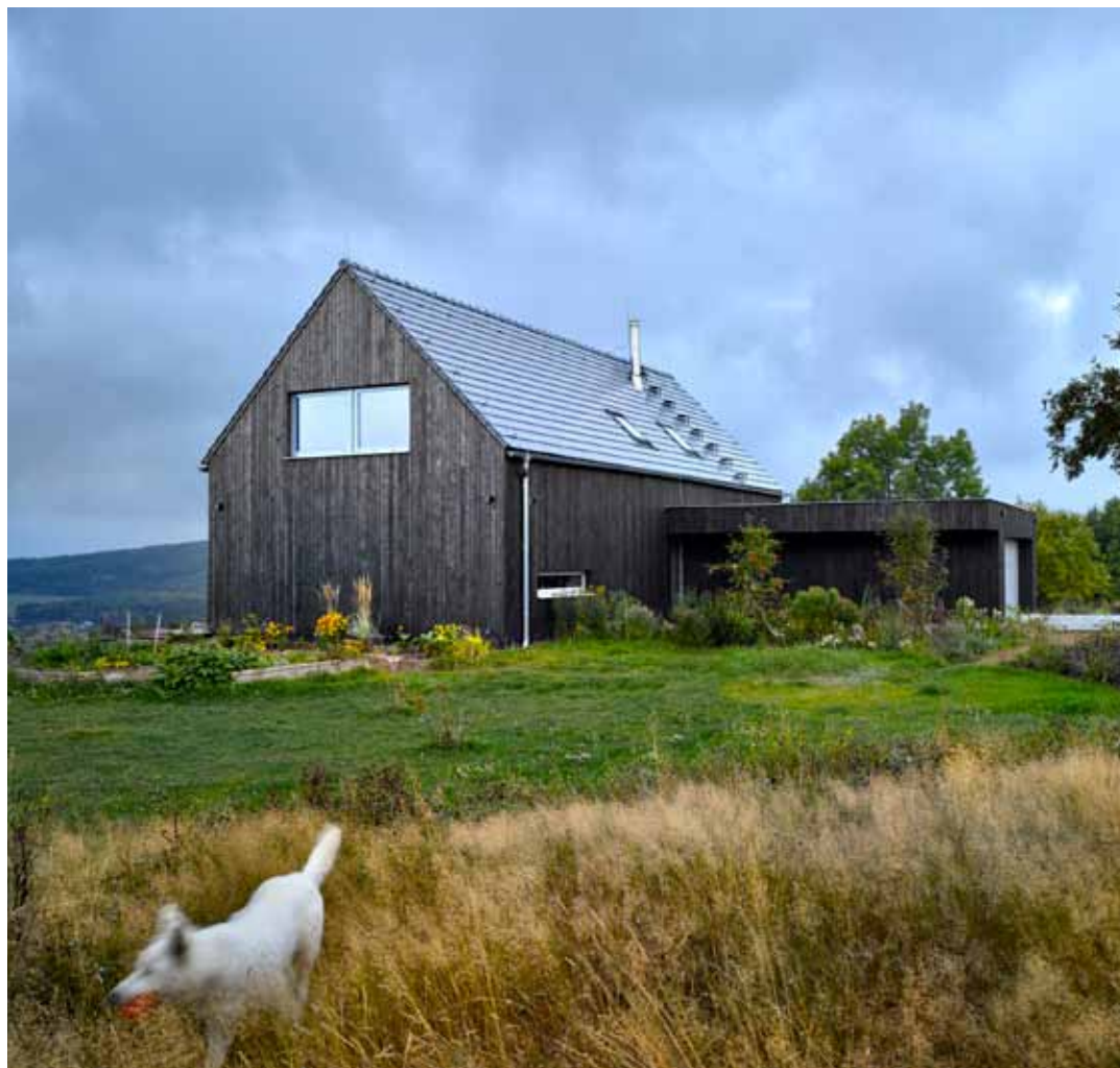
Fasáda domu je z mořeného severského modřínu, okna mají hliníkové rámy. Nosnou konstrukci tvoří zdivo z keramických tvarovek HELUZ Family 25 a doplňujících tvarovek.
