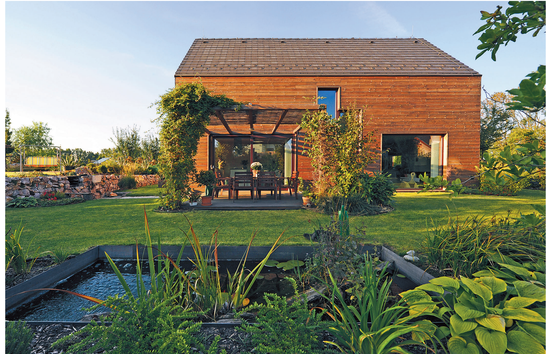
Kompaktní dům se na jižní straně otevírá do nádherné zahrady, navržené Lucií Vogelovou. Toto propojení je zprostředkováno velkými posuvnými dveřmi, které vedou na dřevěnou palubu, chráněnou pergolou.
