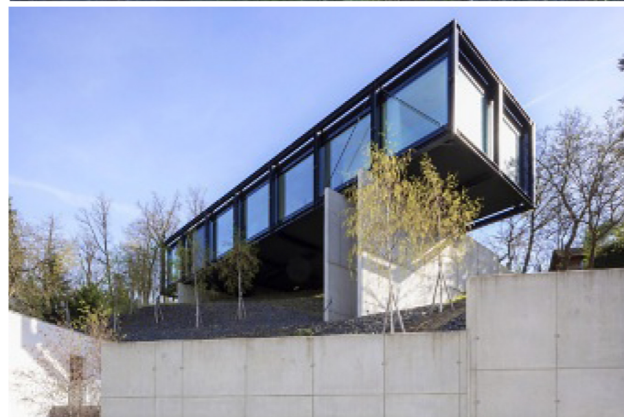
■ Muros de hormigón sostienen la casa.
