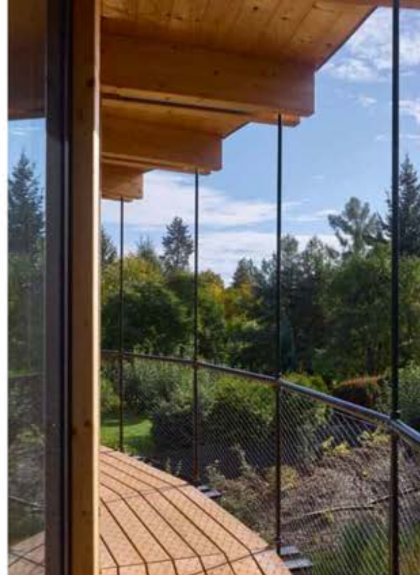
this page_top. 풍출된 지붕과 수평 가리개가 청문을 가려주고, 뒤층의 발코니 역할을 하고 있어 집이 햇빛으로 인해 지나치게 과열되는 것 또한 막아주고 있다. this page_bottom. 욕실은 콘크리트 질감의 견고하고 안정적인 벽을 따라 집중되어 건물의 남북과 북쪽 사이에 균형을 이루고 있다.
