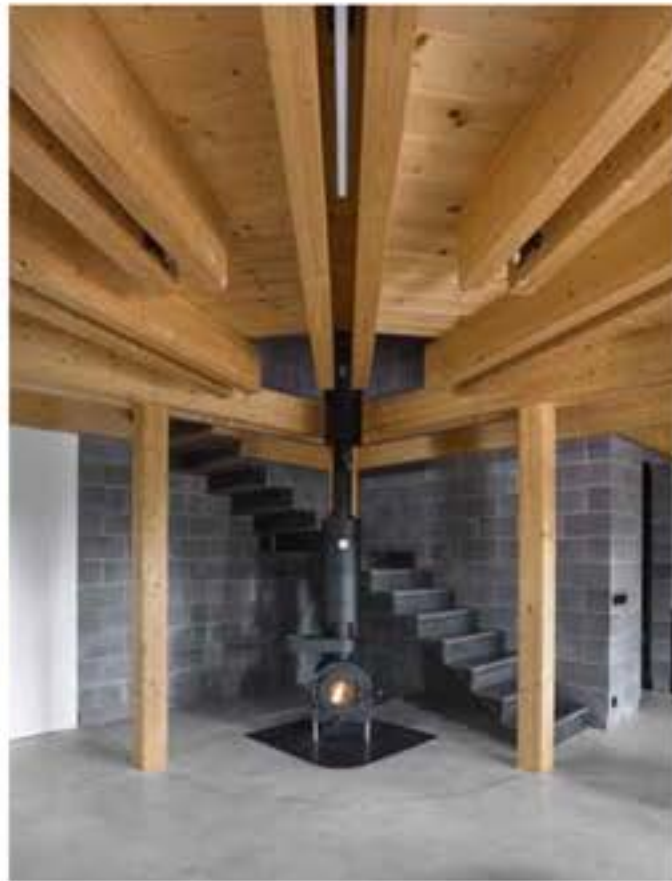
this page_bottom. (좌) 상중 유리 창문에 내장된 블라인드가 여름에도 덥지 않고 편안함을 만드는 데 일조하고 있다. (우) 건물의 자금자국은 거실 중앙에 열 교환기가 있는 난로의 도움을 받고 있으며, 난로 주변으로 구불구불한 계단은 거실 위에 위치한 침실로 이어진다.
